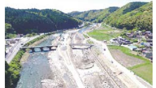
河川の改良工事
